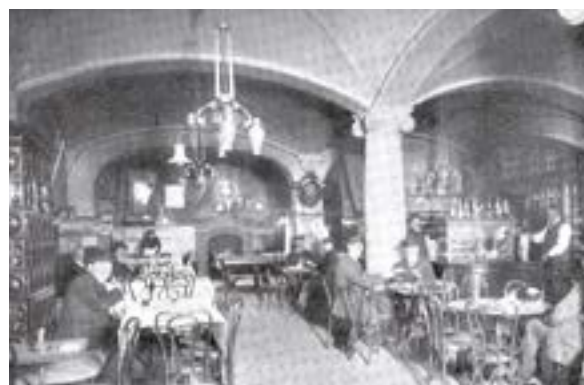
Wirtshaus zur Post an der Centralbahnstrasse (1911)
