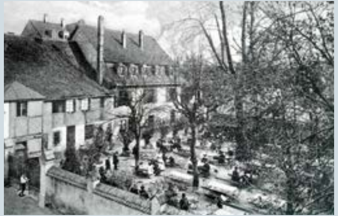
Die Krone an der Dorfstrasse in Kleinhüningen, 1909.
